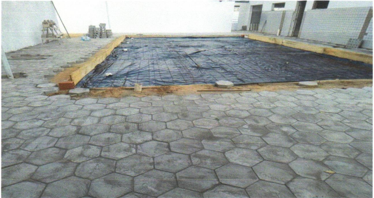
FOTO 13 – APLICAÇÃO DE LONA PLÁSTICA PARA EXECUÇÃO DE PAVIMENTOS DE CONCRETO. AF_04/2022
