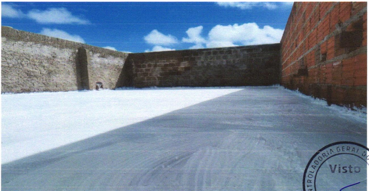
FOTO 22 - IMPERMEABILIZAÇÃO DE SUPERFÍCIE COM EMULSÃO ASFÁLTICA, 2 DEMÃOS AF_06/2018
