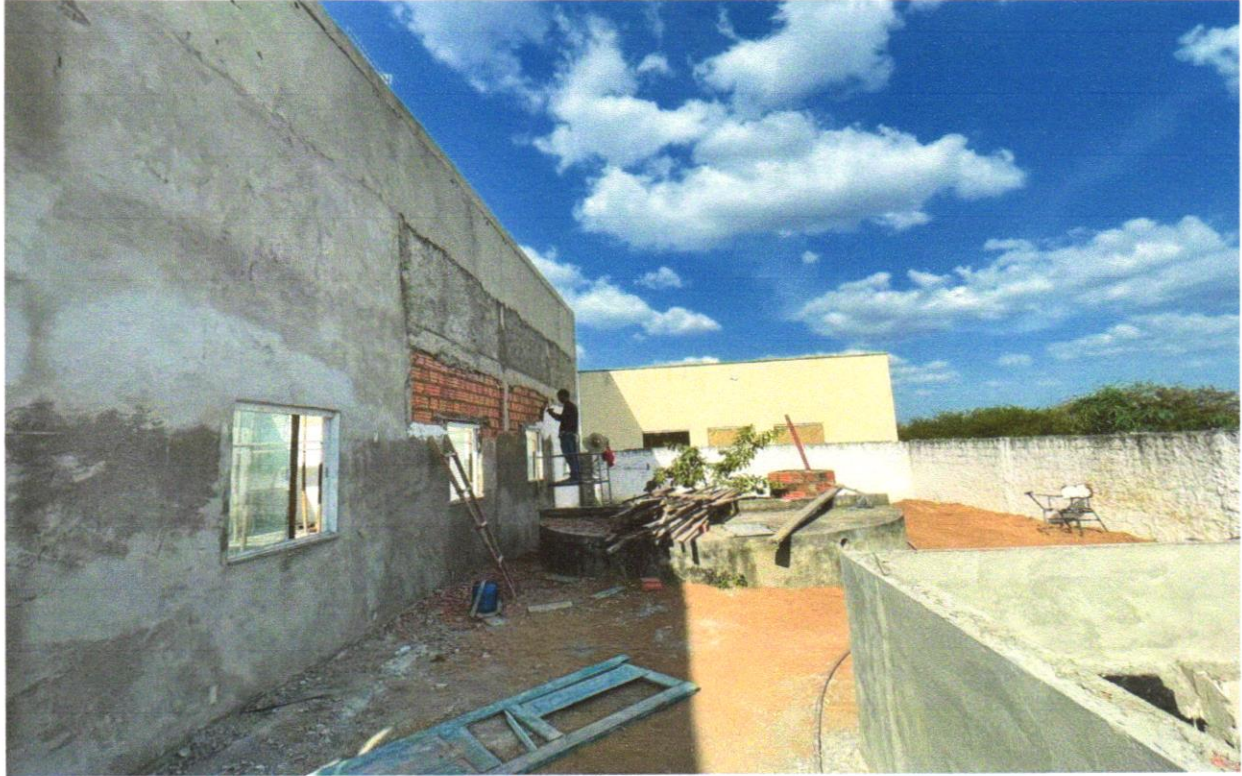
FOTO 05 - VERGA PRÉ-MOLDADA PARA JANELAS COM ATÉ 1,5 M DE VÃO E CONTRAVERGA PRÉ-MOLDADA.
