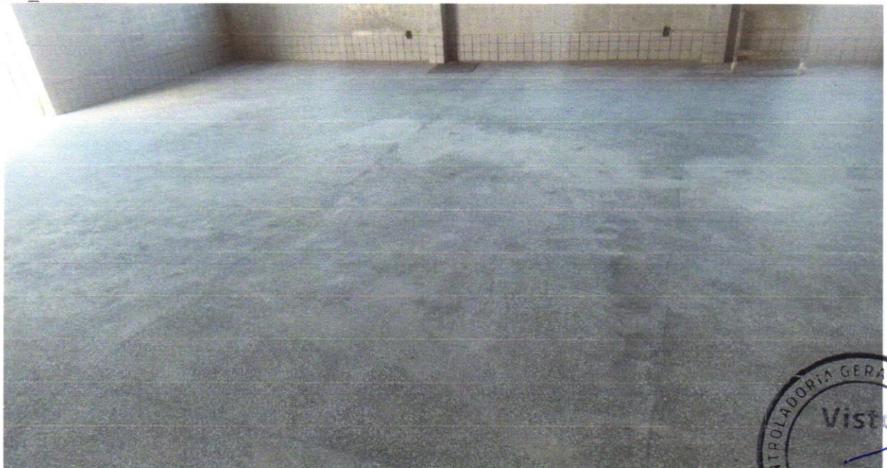
FOTO 16 - PISO EM GRANILITE, MARMORITE OU GRANITINA EM AMBIENTES INTERNOS, COM ESPESSURA DE 8 MM, INCLUSO MISTURA EM BETONEIRA, COLOCAÇÃO DAS JUNTAS, APLICAÇÃO DO PISO, 4 POLIMENTOS COM POLITRIZ, ESTUCAMENTO, SELADOR E CERA. AF_06/2022
