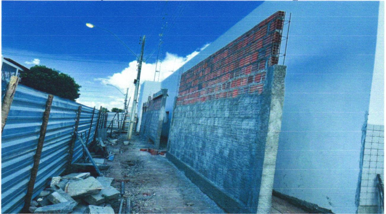
FOTO 21 (COMPOSIÇÃO REPRESENTATIVA) EXECUÇÃO DE ESTRUTURAS DE CONCRETO ARMADO, PARA EDIFICAÇÃO INSTITUCIONAL TÉRREA, FCK = 25 MPA. AF_01/2017
